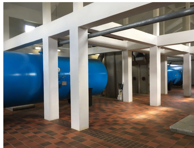
Foto fra filterbygningen i dag med det lukkede filteranlæg og den fritstående søjle-drager konstruktion. Før ombygningen i 1995 var der et stor vandbassin i stedet for fliser. Foto: Lis Engquist, 2021.
