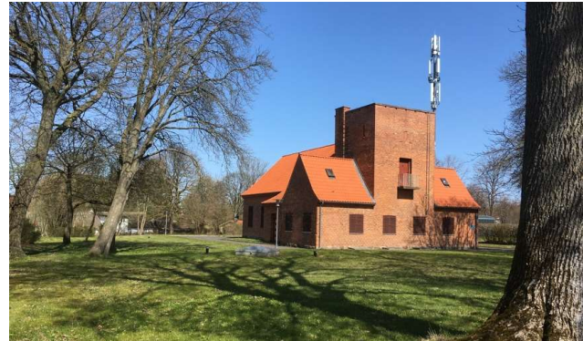
Pumpehuset og den bynære kildeplads ved Taastrup Valby. Foto Lis Engquist 2021. Gamle kildepladser har ofte charme, historie og grønne omgivelser vi sætter pris på i dag. Og fortællingen om vandindvindingen knytter kommunerne sammen på tværs. Hvordan gør vi brug af det i fremtiden?
