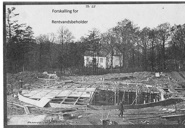
Der laves forskalling til Hennebique-konstruktionen på rentvandsreservoiret. I baggrunden førstestervillaen. Foto: Vandværksmuseets arkiv.
