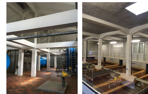
Tv: Iltningbygning fra 1924 med iltningstanke og gulv fra 1985 med reaktionsbassin nedenunder Th: Filtrum fra 1924. Fotos anno 2021.
