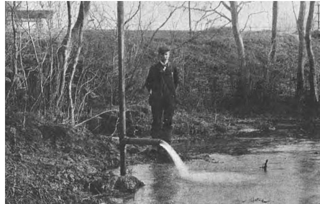
Foto af en undersøgelsesboring ved Store Mølle. Foto fra bogen Københavns Vandværk, 1909.
