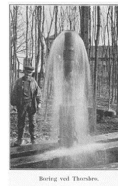
Boring ved Thorsbro. Kbh. Vandværk 1859-1909, s. 92
